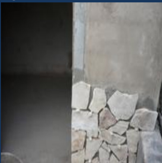
Beginn der Natursteinarbeiten
