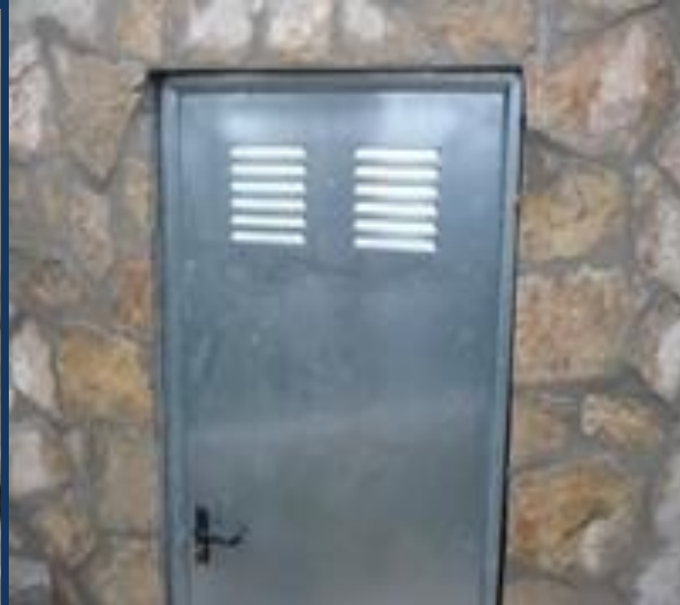
Fertigstellung der Natursteinarbeiten.
